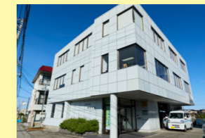
富山県富山市の新栄電設は、商業施設から住宅まで幅広い電気・通信・消防・冷暖房などの設備工事を行う。
